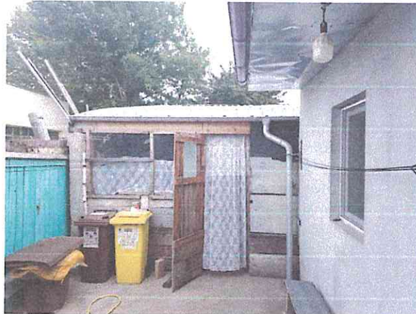
Constructia C3 - Anexa
