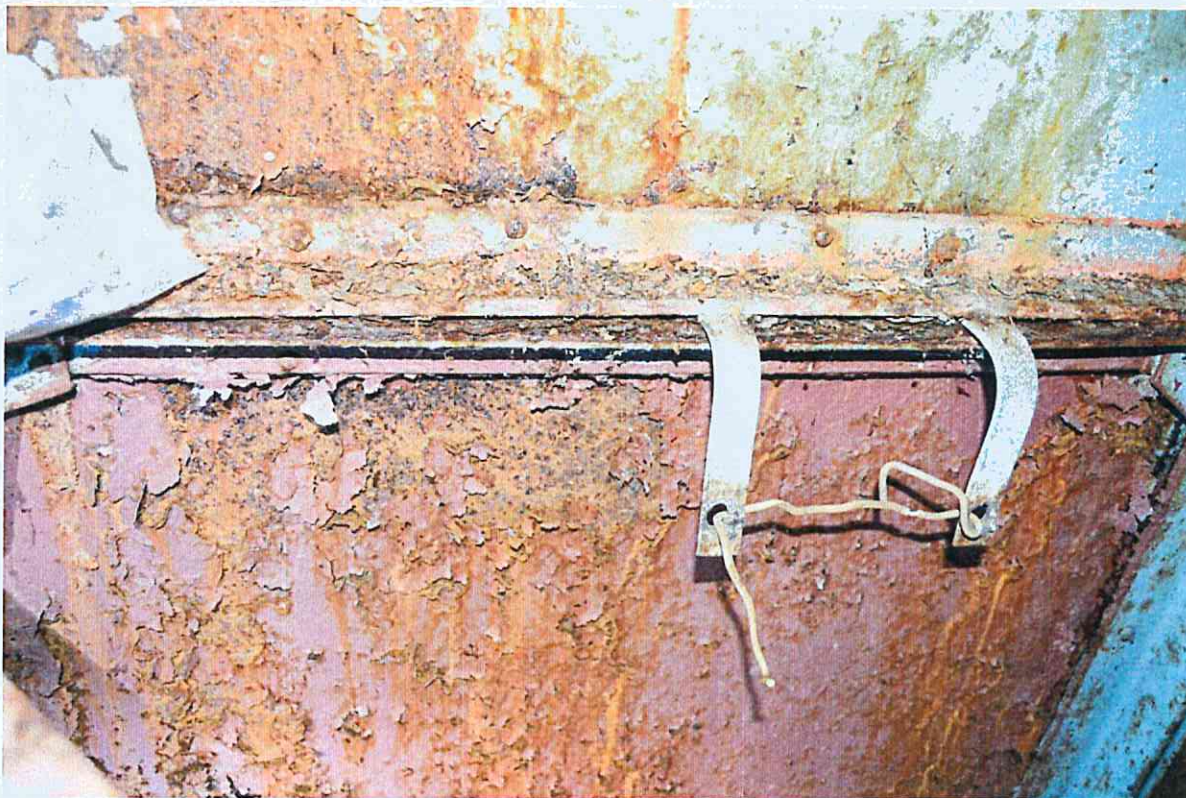
Fig.9 Fața nordică a bazei, unde este amplasată și ușa de acces (interior)
