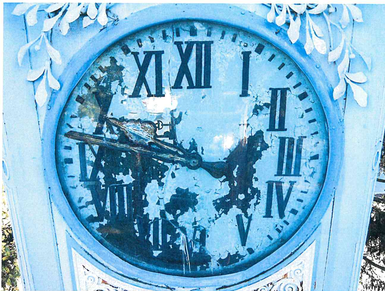
Fig. 18 Detaliu cu unul din cadranele ceasului, cu mari degradări.
